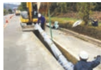
水道管の取り替え工事
